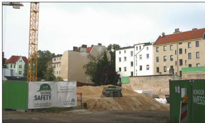
... und so sieht zurzeit aus: Das alte Fabrikgebäude ist abgerissen, die Kräne für den Neubau stehen. Foto: Bothe
