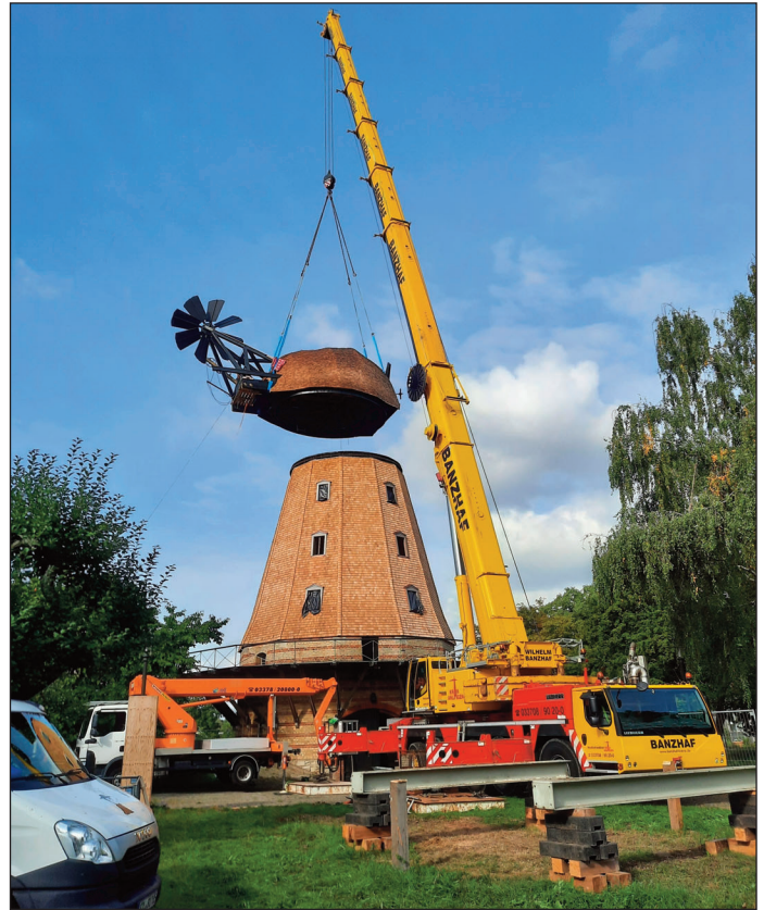
Mit spektakulären Kranarbeiten wurde unter anderem die 20-Tonnen schwere Kappe abgehoben. Fotos: GrünBerlin
